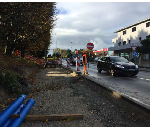
Installation des conduites d'eau potable dans le secteur sud-est de la route de Bottens
