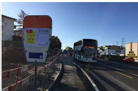
Mise en place des bordures surélevées de l'arrêt de bus Cugy-Moulin ayant nécessité un déplacement provisoire du lieu de prise en charge des usagers
