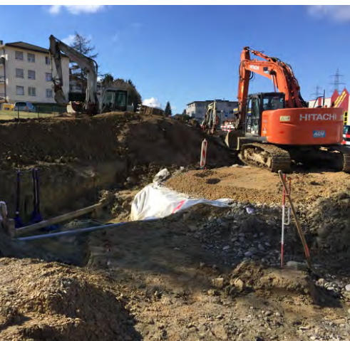
Travaux de fouille pour la rénovation des conduites d'eau potable et réalisation des encaissements du giratoire et de ses branches dans le secteur nord-est de la route de Bottens
