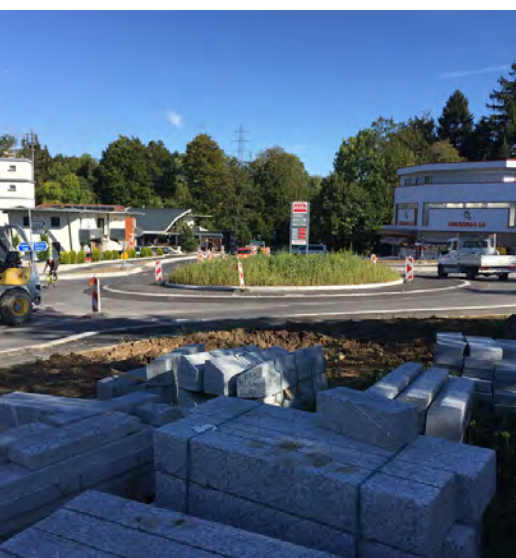
Mise en place des bordures dans le secteur du giratoire et création de marches d'escaliers pour l'accès piétonnier au chemin du Moulin
