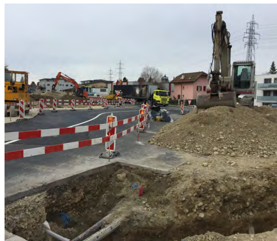
Travaux de fouille pour la rénovation des conduites d'eau potable et réalisation des encaissements du giratoire et de ses branches dans le secteur nord-est de la route de Bottens
