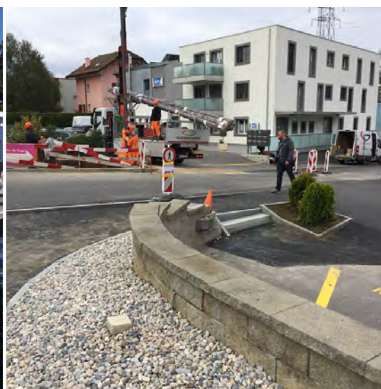
Mise en place des bordures dans le secteur du giratoire et création de marches d'escaliers pour l'accès piétonnier au chemin du Moulin
