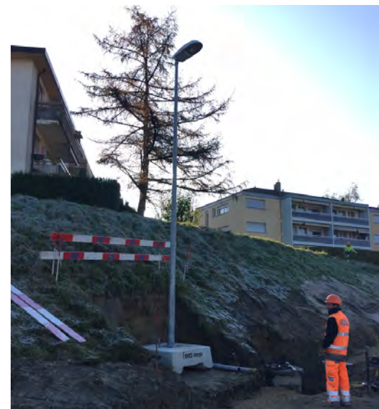
Installation d'un éclairage provisoire au droit du débouché du chemin des Petits-Esserts
