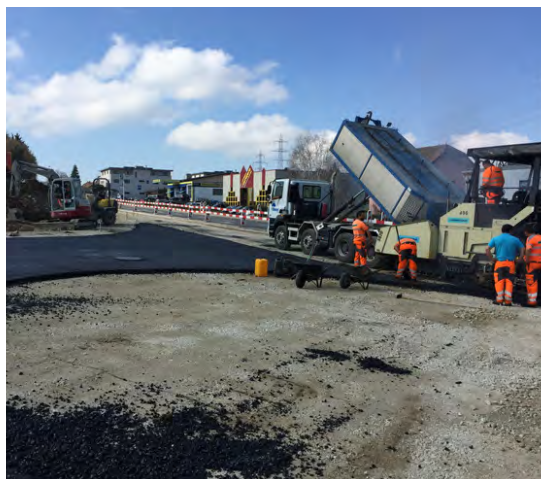
Travaux de fouille pour la rénovation des conduites d'eau potable et réalisation des encaissements du giratoire et de ses branches dans le secteur nord-est de la route de Bottens
