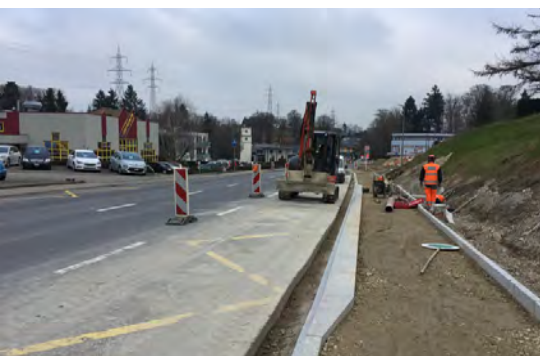
Mise en place des bordures surélevées de l'arrêt de bus Cugy-Moulin ayant nécessité un déplacement provisoire du lieu de prise en charge des usagers
