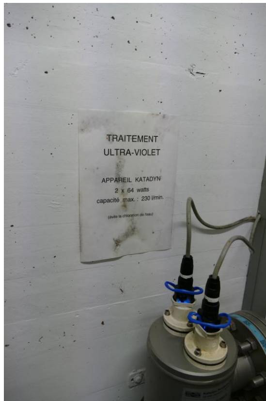
Traitement ultra-violet de l'eau de nos sources captées à proximité « d'en Billard »
